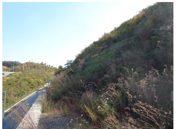
상부 성토부 전경
