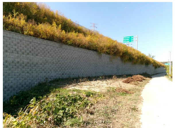
상부 성토부 전경
