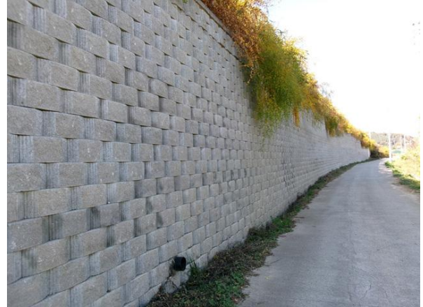
지반 기초부 상태양호
