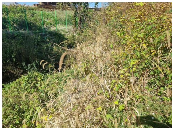
상부 성토부 전경
