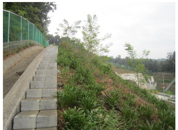
상부 성토부 전경
